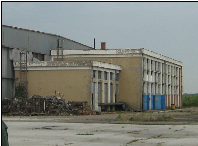
Mašinska radionica sa trafo stanicom
