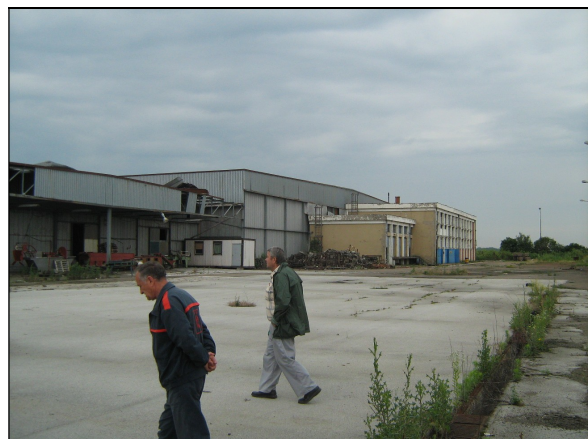
Hladnjača – pogled iz dvorišta
